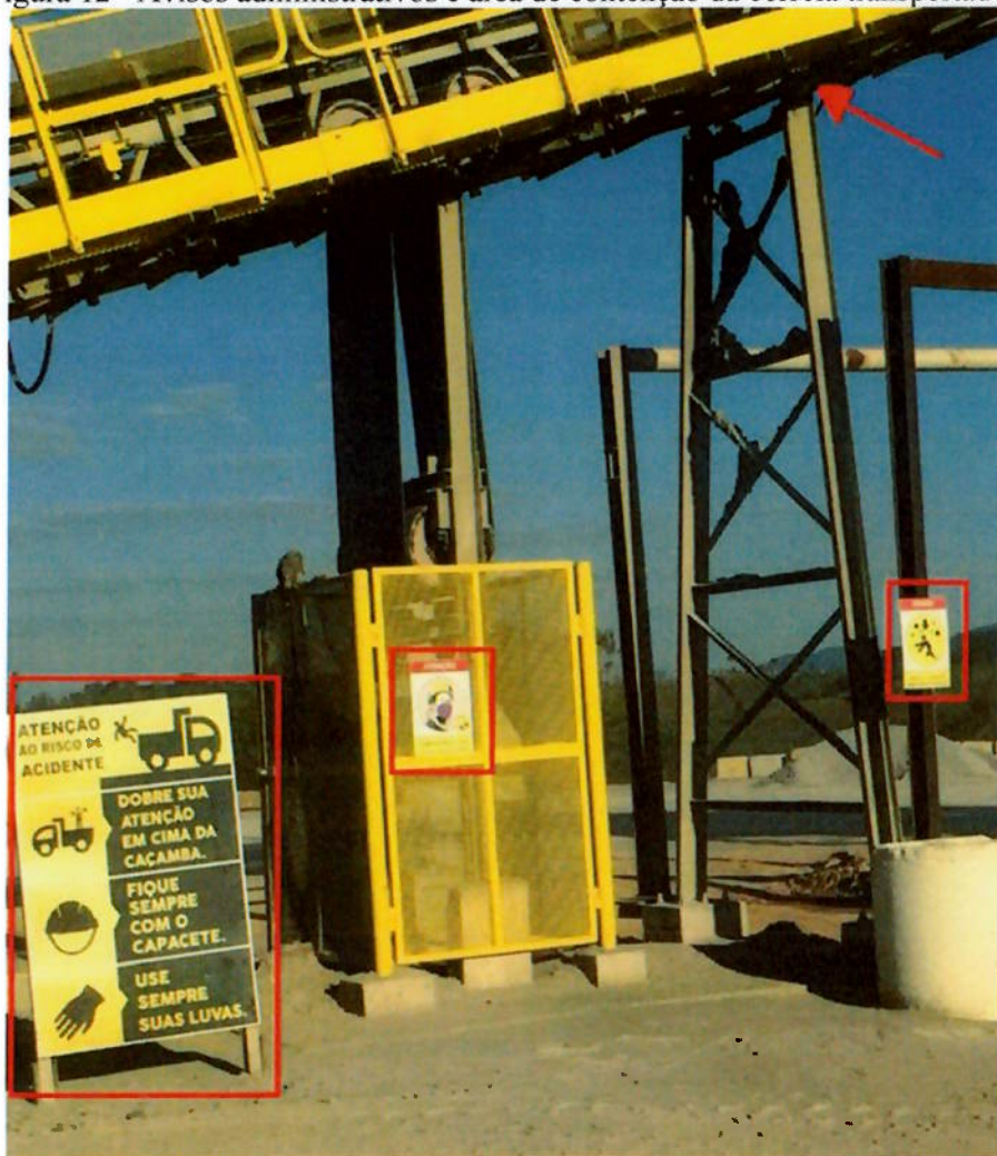
Figura 12 - Avisos administrativos e área de contenção da correia transportadora
