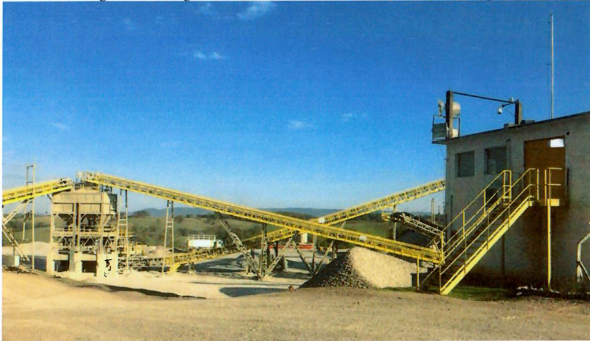
Figura 10 - Britagens secundária e terciária e sala de controle da britagem
